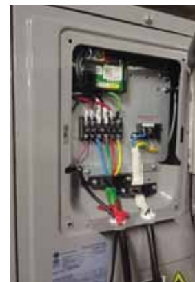
2. Deslice el panel hacia abajo para liberar los ganchos y empuje hacia fuera.
