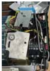
4. Retirez le couvercle de la boîte électrique.
