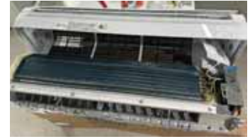
3. Retire la tapa desinstalando estos 10 tornillos.
