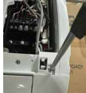
2. Retire el panel del marco derecho.
