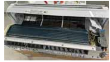
3. Enlevez le couvercle en retirant ces 10 vis.
