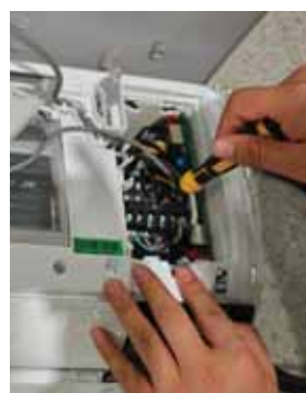
4. Retirez 1 vis pour retirer le bornier (modèles QS06WP2BE* seulement).
