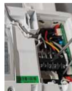
4. Retire 1 tornillo para quitar el bloque termina (modelos QS06WP2BE* únicamente)
