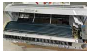
3. Retire la tapa desinstalando estos 10 tornillos.
