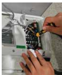
4. Retire 1 tornillo para quitar el bloque termina (modelos QS06WP2BE* únicamente)
