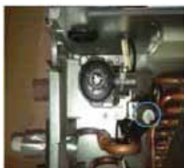
Bomba de Condensación Empotrada e Interruptor Flotante
